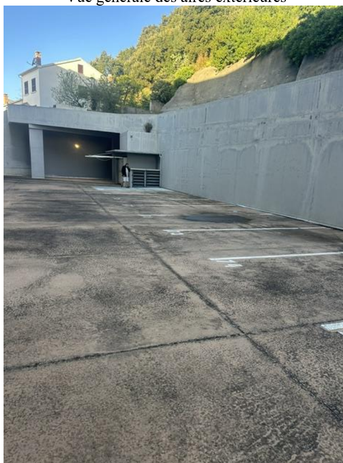
Vue générale des aires extérieures
