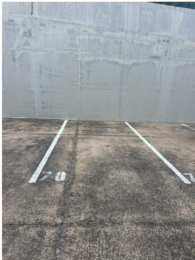
Aires extérieures 68 et 70
